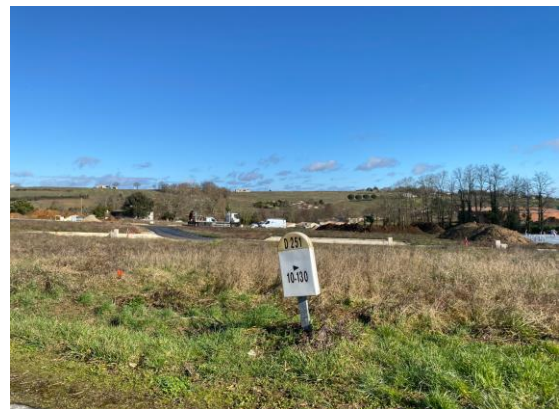
Logements en construction // Source : crédit photo MERC/AT
