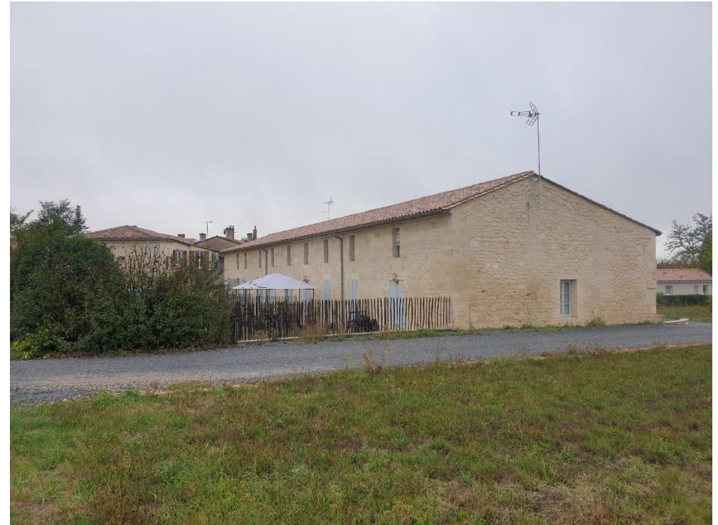
Logement réhabilité dans le cadre de la 2 ème OPAH sur Saint-Gervais // crédit photo MERC/AT
